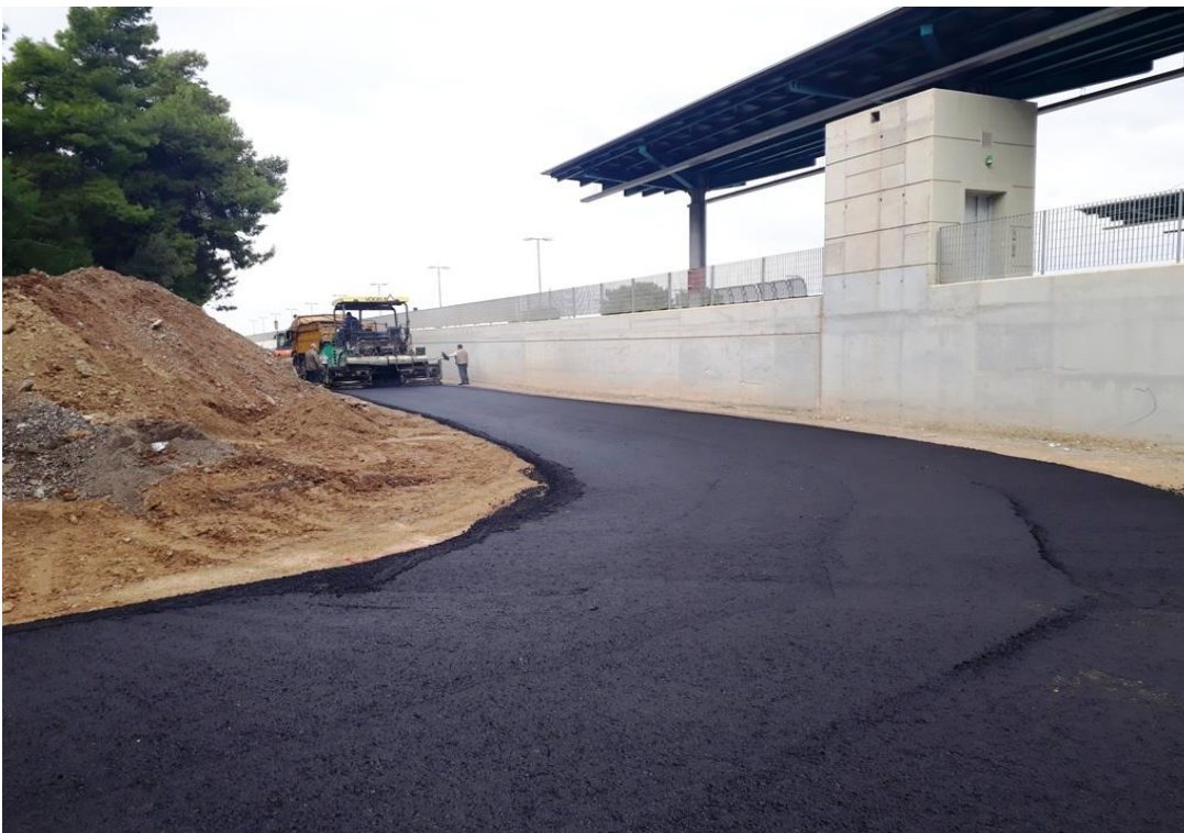
Εργασίες ασφαλτόστρωσης σε πλευρική οδό
