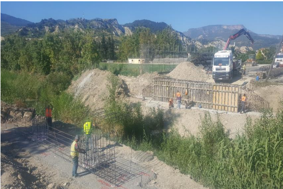
Κατασκευή προσωρινής γέφυρας A1-A2
