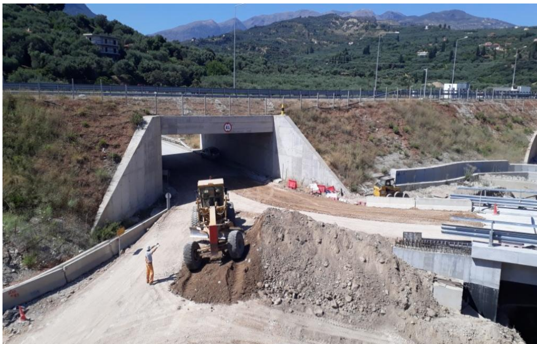
Κατασκευή τεχνικού Β254
