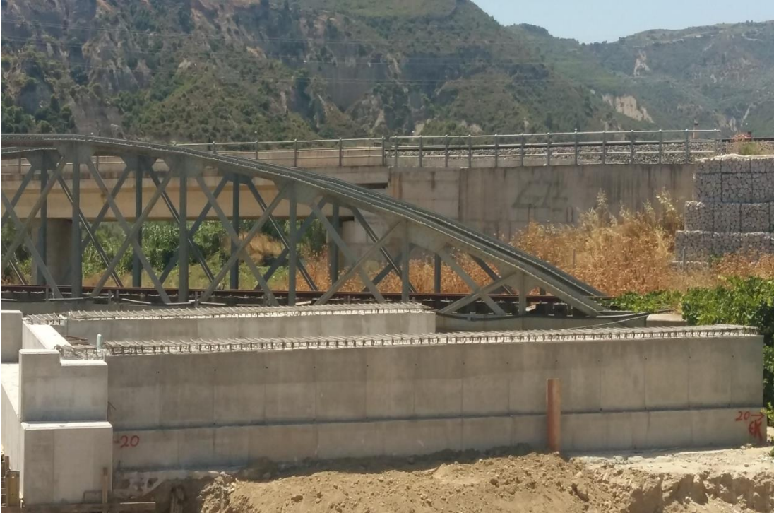
Κατασκευή γέφυρας ποταμού Σύθα
