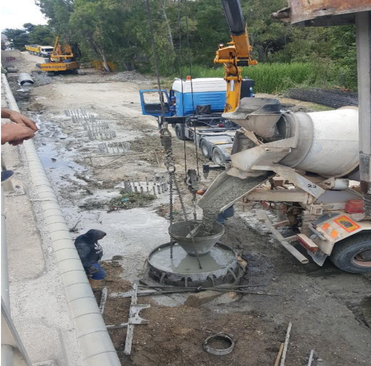
Κατασκευή πασαλοτοίχου
